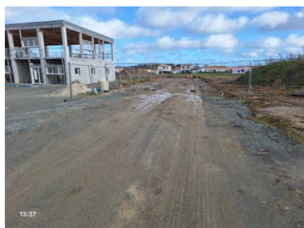
Voirie côté rue Pasteur
